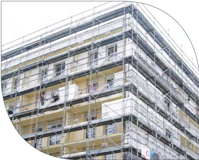
Le Système **EDIL-Therm®** est un procédé d'Isolation Thermique par l'Extérieur (ITE) par enduit mince sur isolant en polystyrène expansé (PSE) ou en Laine de Roche.
